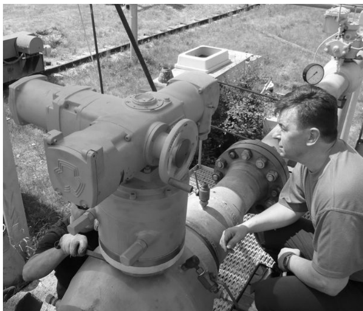
Рисунок 13 – Крепление редуктора с приводом на арматуре
