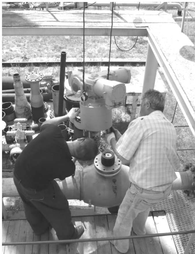
Рисунок 12а – Установка электропривода с редуктором на арматуру
